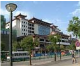
西安市内の建築中のホテル
