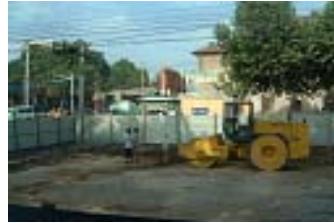
西安市内近くの道路工事
